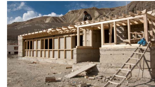
Hrubá stavba prvního patra internátu
