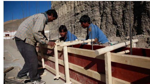
Bednění stěn z dusané hlíny
